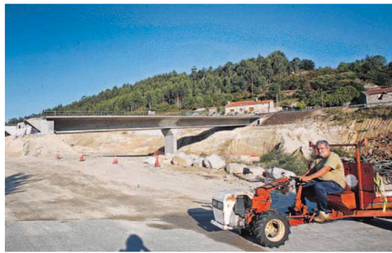
Obras en marcha de la A-57 entre Vilaboa y A Ermida, único tramo en el que hay trabajos. CAPOTILLO
