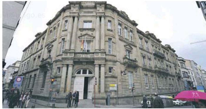
Edificio que acoge la sede la Agencia Tributaria en Ourense.
