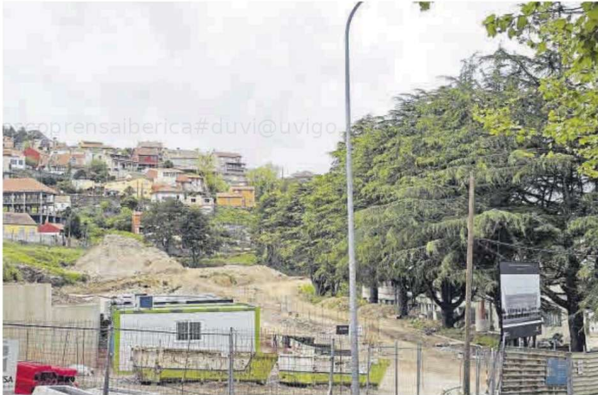
Estado de las obras en marcha en el ámbito PS-6, donde se construirá la residencia de mayores.
